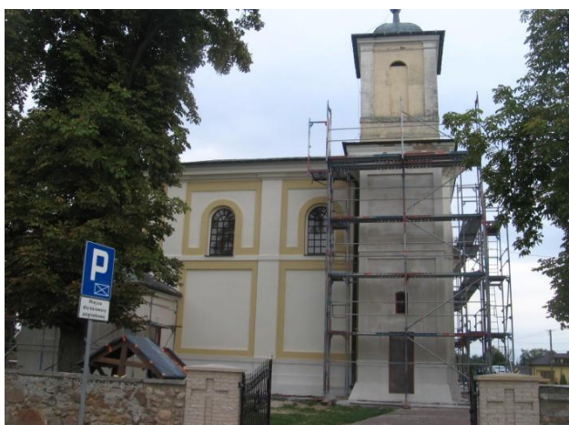
Trwający remont w kościele w Lisowie
